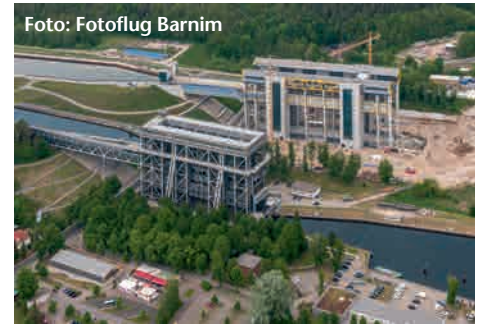
Foto: Fotoflug Barnim Parallel zum bisherigen Hebewerk wurde das Schiffshebewerk Niederfinow Nord errichtet und am 4.10.22 nach langer Verzögerung eingeweiht.
