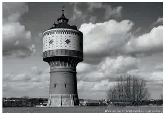
„Wasserturm Mittweida“ von Frank Brautzsch
